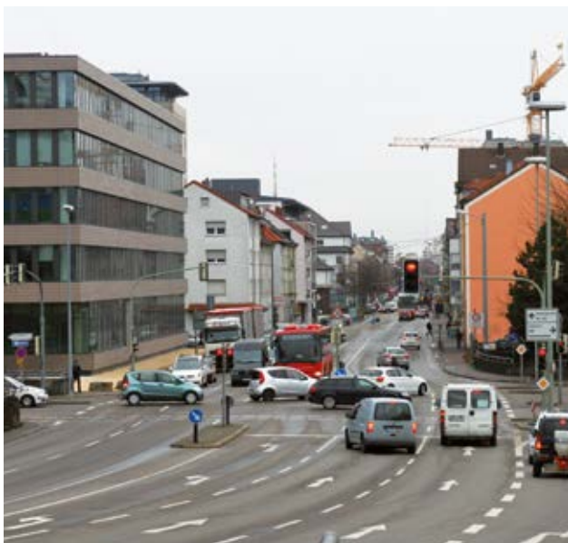
Karlstraße vor dem Umbau.
