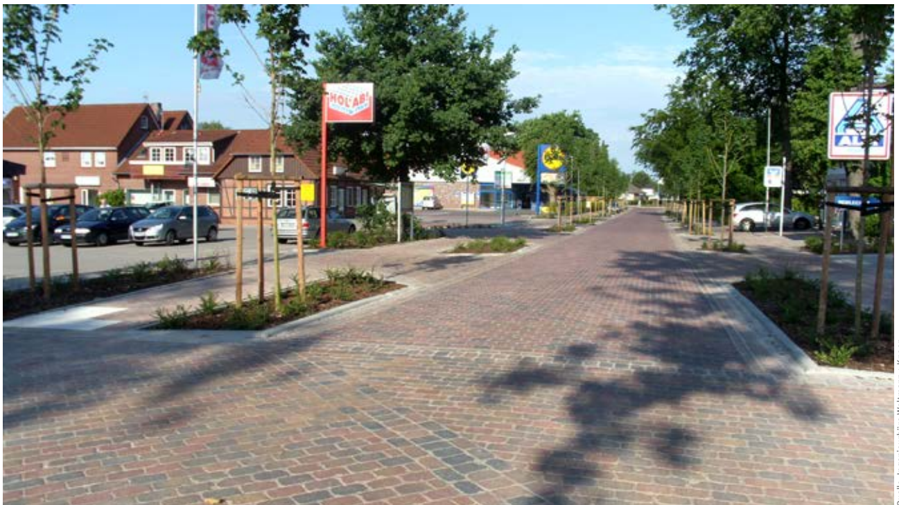
Die Zufahrten zu den Parkflächen der Einzelhändler wurden in die Straßengestaltung integriert.
