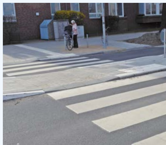
Getrennte Querungsstellen bieten sowohl eine Nullabsenkung als auch ein 6 cm hohes Bord.
