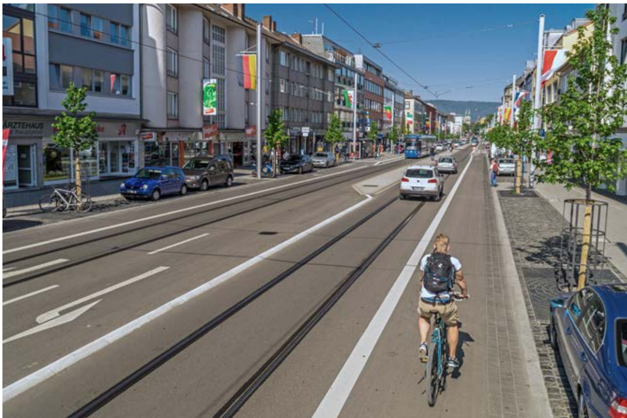
Durch eine effiziente Aufteilung der Verkehrsflächen konnten ein durchgängiger Radfahrstreifen sowie – auf weiten Teilen – auch ein als Querungshilfe dienender Mittelstreifen errichtet werden.
